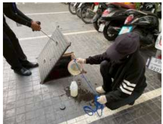
น้ำออกจากระบบบำบัดน้ำเสียขนาด 60 ลบ.ม. อาคาร A1
